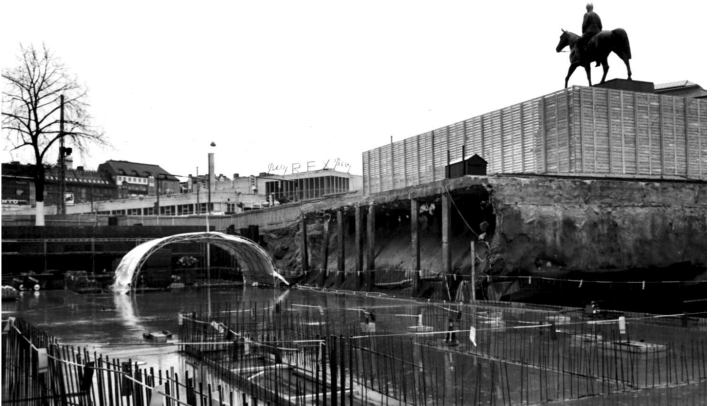
Kiasmaa rakennetaan, kuva: Kuvataiteen keskusarkisto
